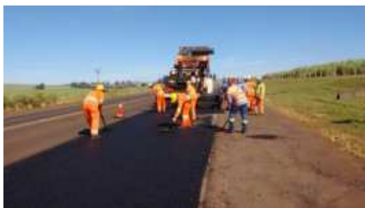
Figura 10 – Obras em Andamento
