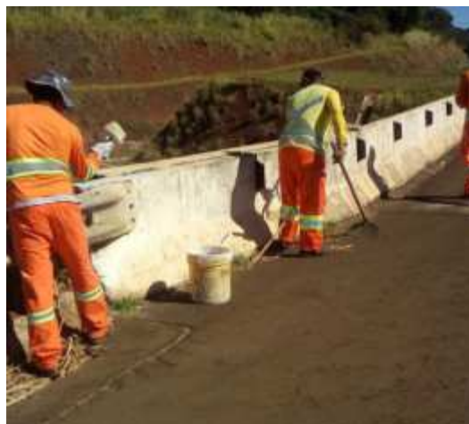
Figura 11 – Obras em Andamento
